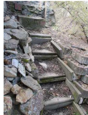
schodiště ze dvora na zahradu a skálu
