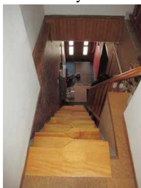
schodiště - pohled shora
